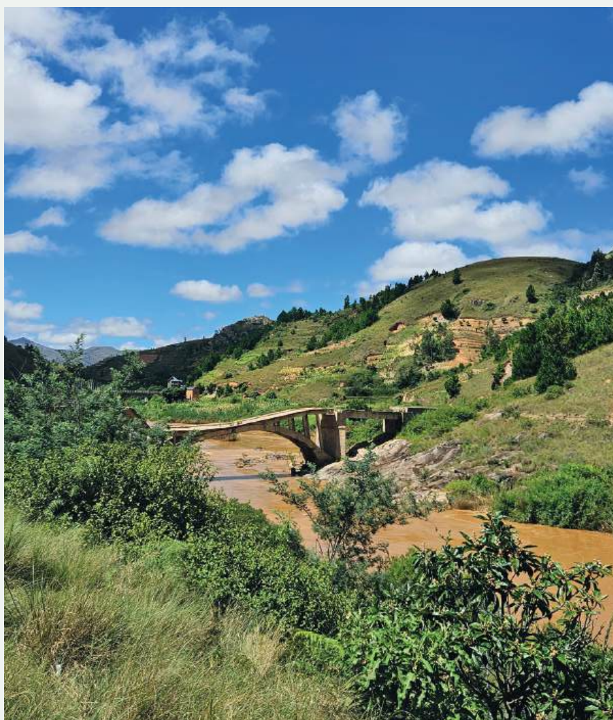
Broen knakk en gang for lenge siden, og er aldri blitt reparert.
